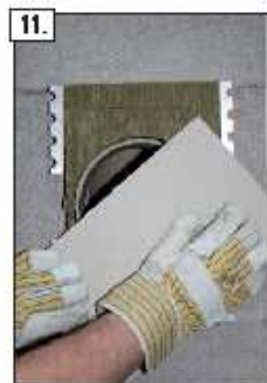
10. Spingere il pannello e i ganci di fissaggio all'interno della camicia, con l'aiuto della sagoma di taglio inserite a filo dell'imboccatura dell'allacciamento.
