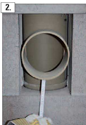
1. Prendete le misure al di sotto e al di sopra dello stacco dell'allacciamento rispetto al filo della camicia
