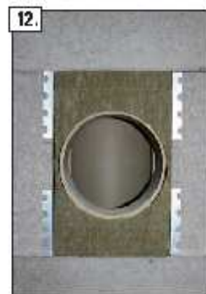
10. Spingere il pannello e i ganci di fissaggio all'interno della camicia, con l'aiuto della sagoma di taglio inserite a filo dell'imboccatura dell'allacciamento.
