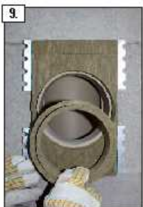
8. Rimuovete le membrane estraibili dal pannello secondo il diametro di riferimento della derivazione dell'allacciamento
